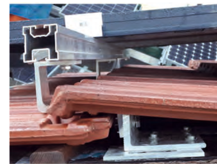
ÉTAPES DE FIXATION DE L'ACCESSOIRE SUR TOITURE EN TUILES
